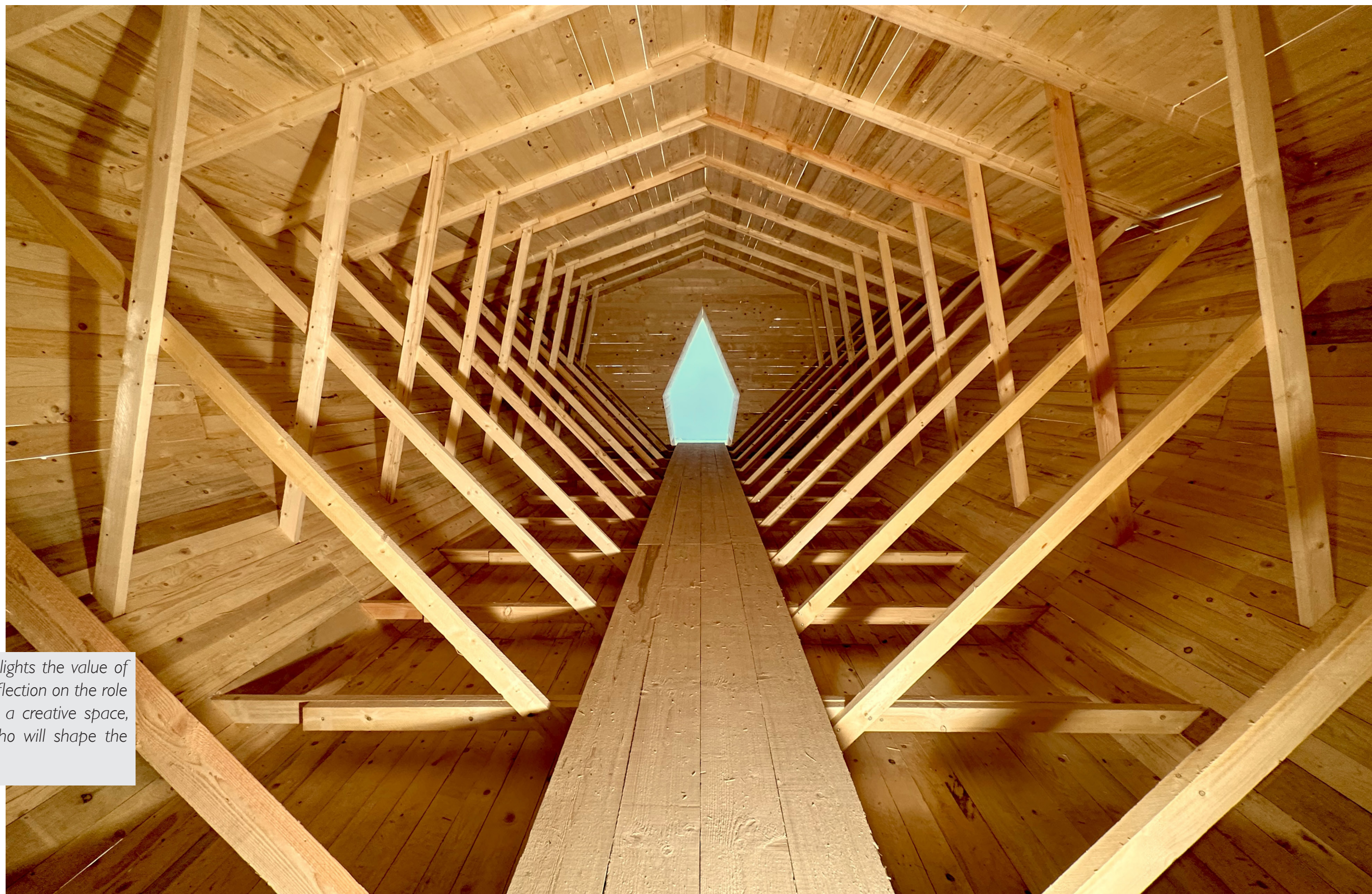
ArkiZoic Project XIII, il cantiere.
