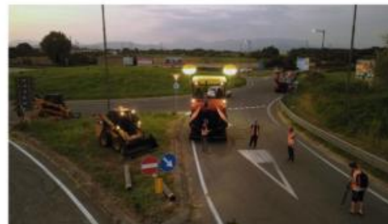
2. Un cantiere stradale in notturna: sistemi di illuminazione e avvisatori acustici sono fondamentali per la sicurezza
