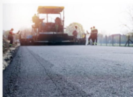
5. Alte temperature del conglomerato in fase di stesa, fumi, rumori, vibrazioni della macchina sono fra gli elementi che possono avere conseguenze sulla salute degli addetti se non si usano le corrette precauzioni e la giusta attenzione
