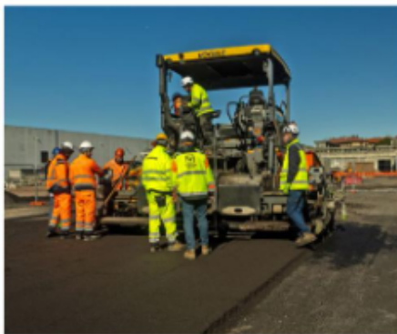
3. Vibrofinitrice: anche durante il settaggio del banco di stesa, l'attenzione alla sicurezza degli operatori nelle vicinanze del mezzo in movimento rimane sempre massima
