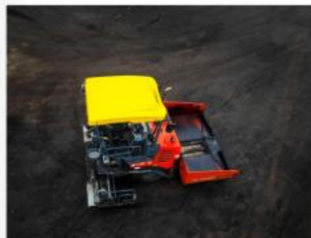
1. Una vibrofinitrice, mezzo onnipotente nei cantieri stradali. I rischi connessi al suo utilizzo possono essere mitigati con corretta formazione del personale, il rispetto delle normative e l'utilizzo di dispositivi di sicurezza certificati
