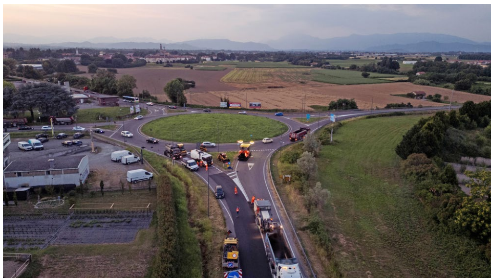
4. Tecnici ESEM-CPT seguono le ditte durante i lavori
