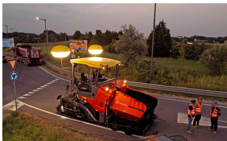
5. La finitrice utilizzata per rifare il mantello stradale in seguito alla scarifica effettuata con la fresatrice
